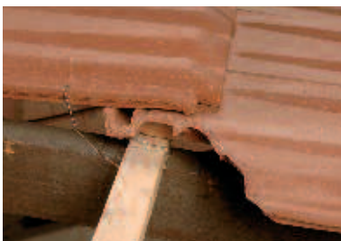
Fixation des tuiles en plain carré pour tenue au vent par crochet Mono* ( le choix du crochet Mono dépend de la section du liteau )
