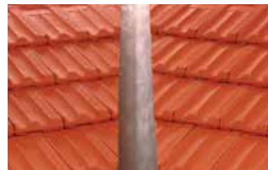
Les tuiles sont tranchées biaisées parallèlement à l'axe de la noue.
