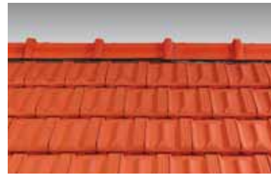
Faîtage réalisé à sec avec faitières losangées à emboîtement et closoir ventilé, sans emploi de mortier.
