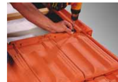
Fixation des tuiles en rive latérales, gauche et droite, par vis et rondelle d'étanchéité.
