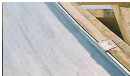
Mise en place de la noue métal façonnée à relevés, contre liteau filant et patte de fixation.
