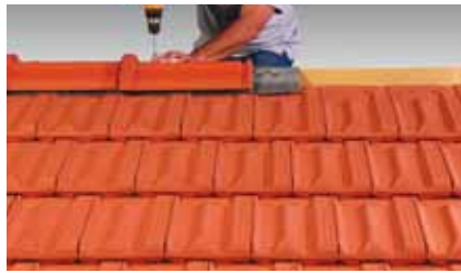
Après mise en place du closoir ventilé, les faitières sont vissées dans la lisse de rehausse.
