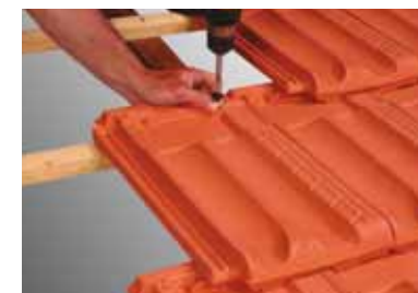
Fixation des tuiles en plain carré pour tenue à forte pente, par vis et rondelle d'étanchéité.
