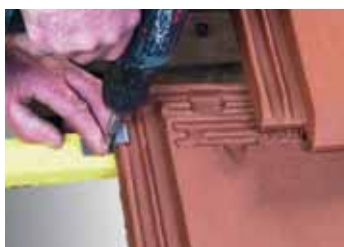
Fixation des tuiles en plain carré pour tenue à forte pente, par crochet "PM" Réf. CRP03.
