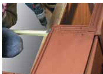
Fixation des tuiles en rive latérale droite par crochet "PM" Réf. CRP03.
