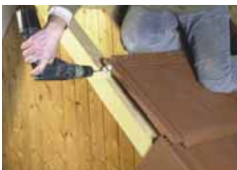
Fixation des tuiles en rive latérale gauche par crochet "PM" Réf. CRP03, rabattu contre l'extrémité du liteau.
